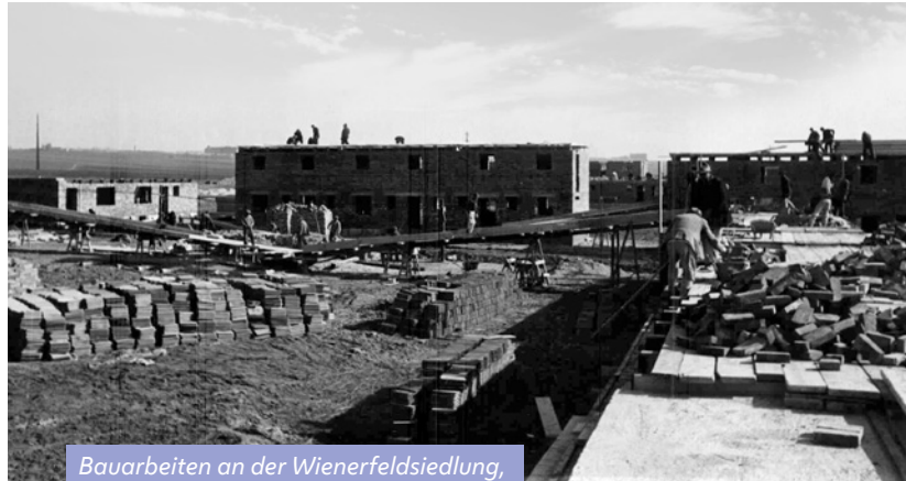
Bauarbeiten an der Wienerfeldsiedlung, Fotografie datiert mit 1. 1.1939.
