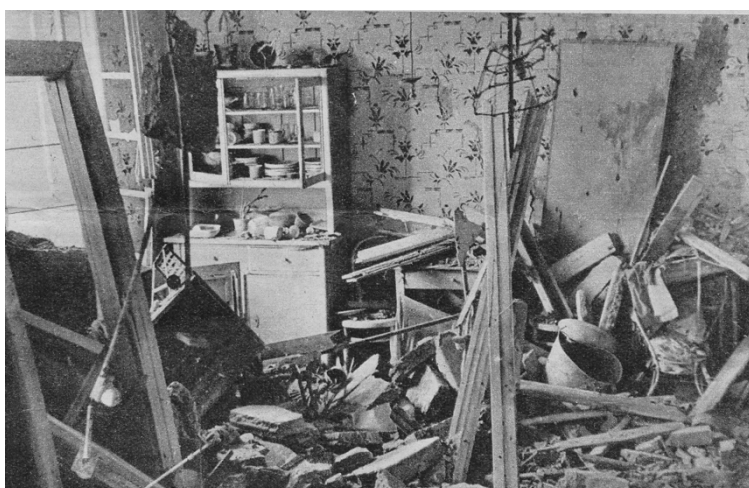
Abb. 1. Zerstörte Wohnungen (Februarkämpfe 1934)
