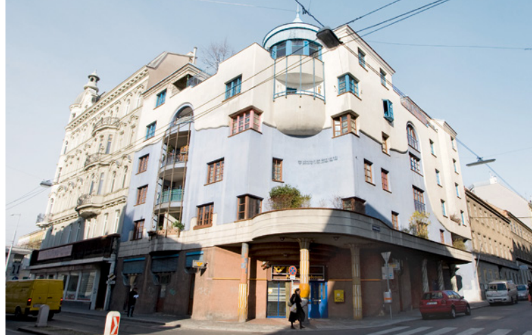
Wohnhausanlage Wallgasse 13, 6. Bezirk
